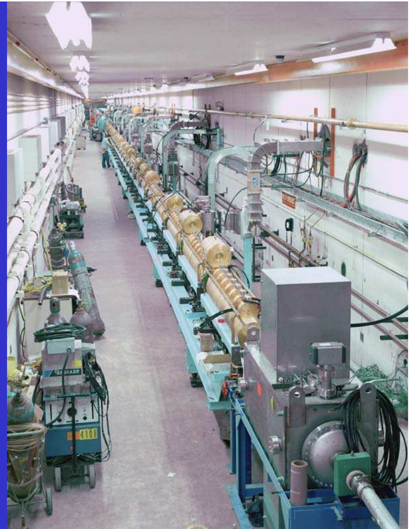
FERMILAB - LINIAC (tunel)
