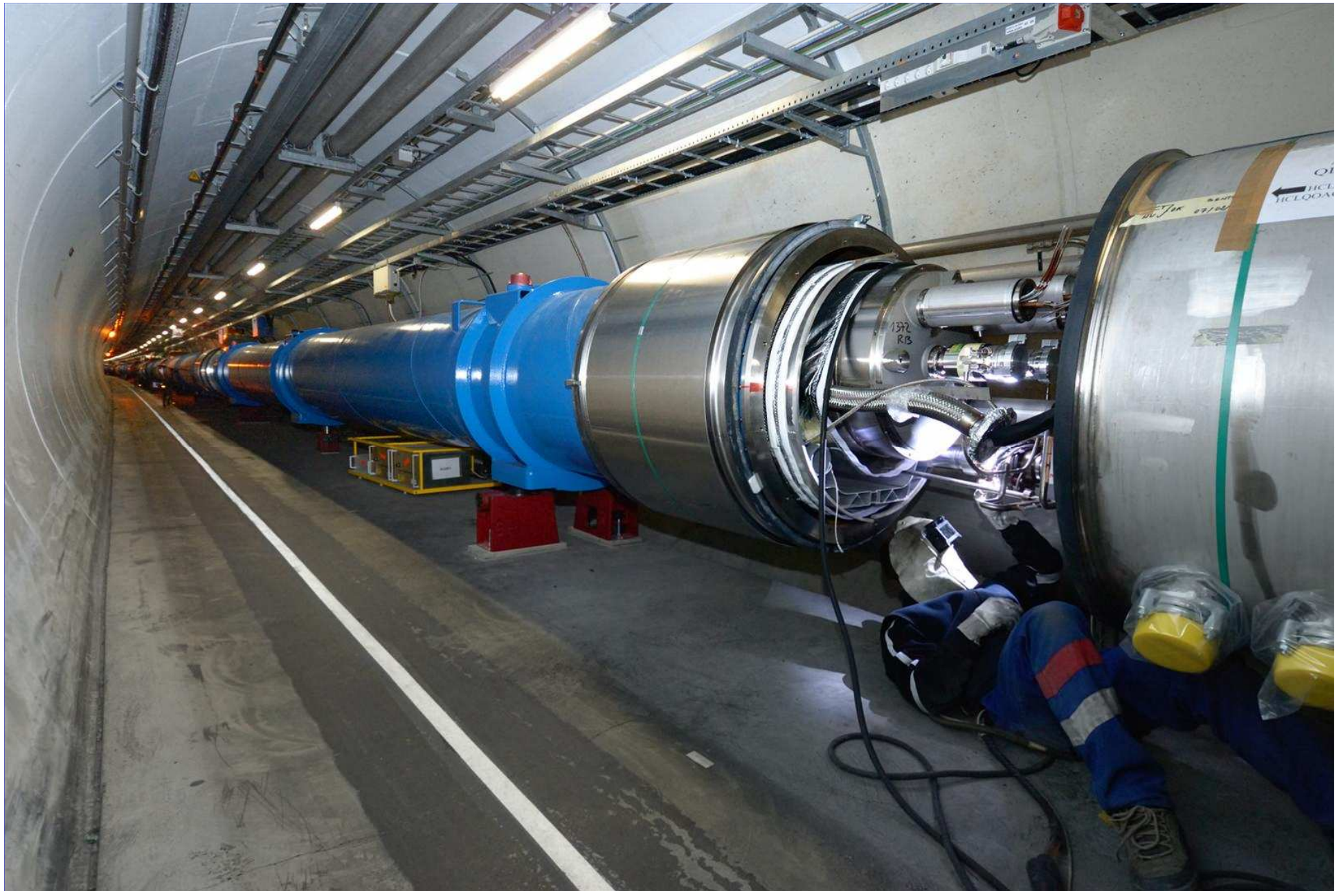
LHC - kolejne stadia budowy.
