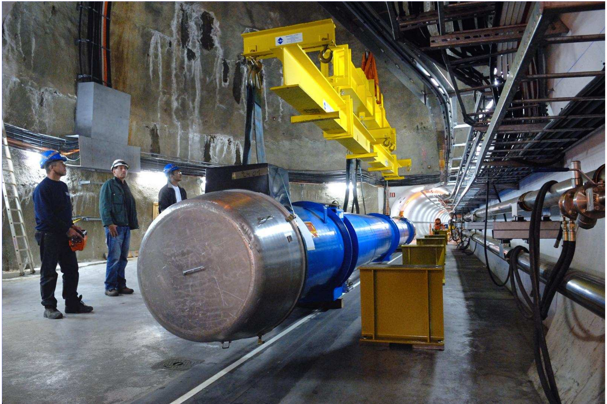
LHC - kolejne stadia budowy.
